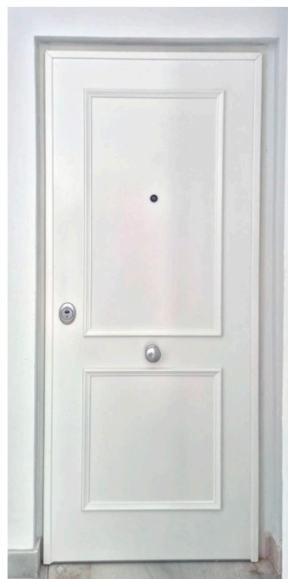
EJEMPLO PUERTA CON BISAGRA OCULTA Y APERTURA EXTERIOR
